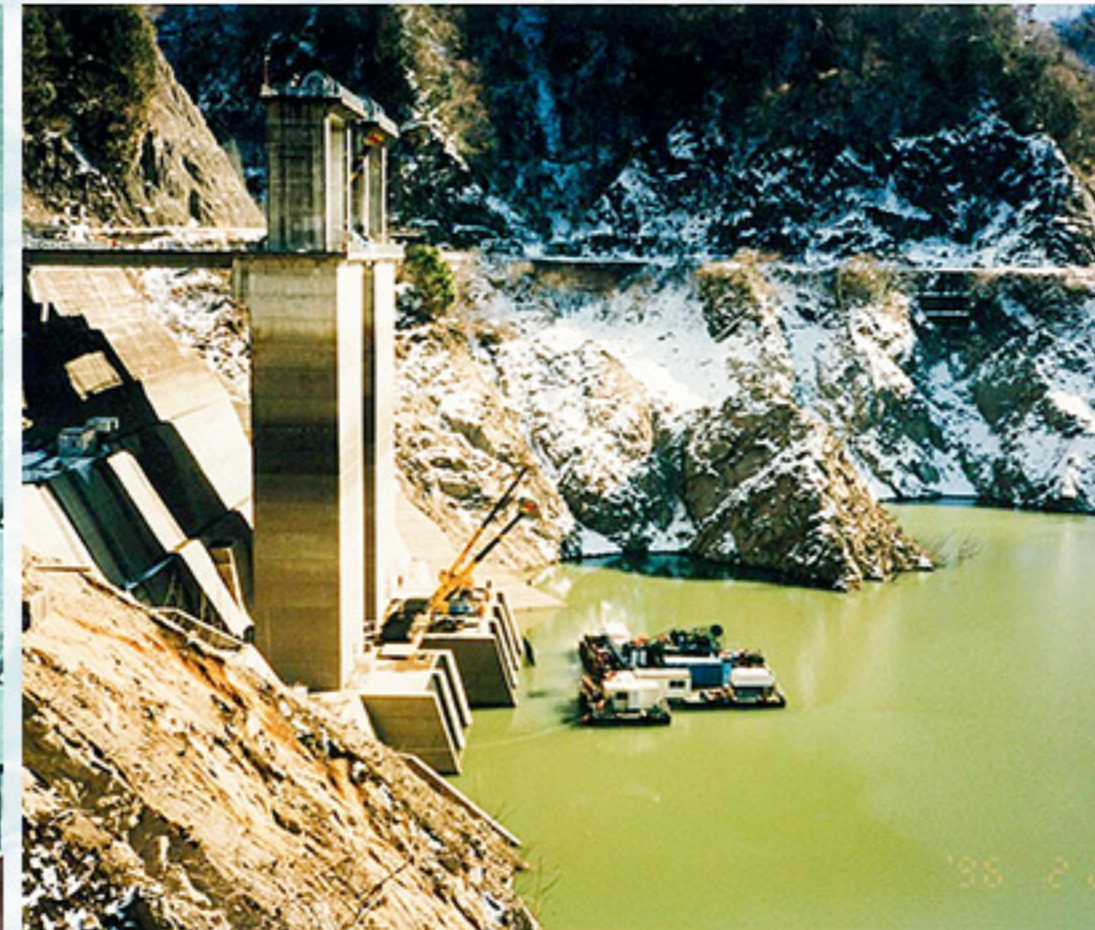
ダム湖スクリーン改修工事 Maintenance of water dam screen
