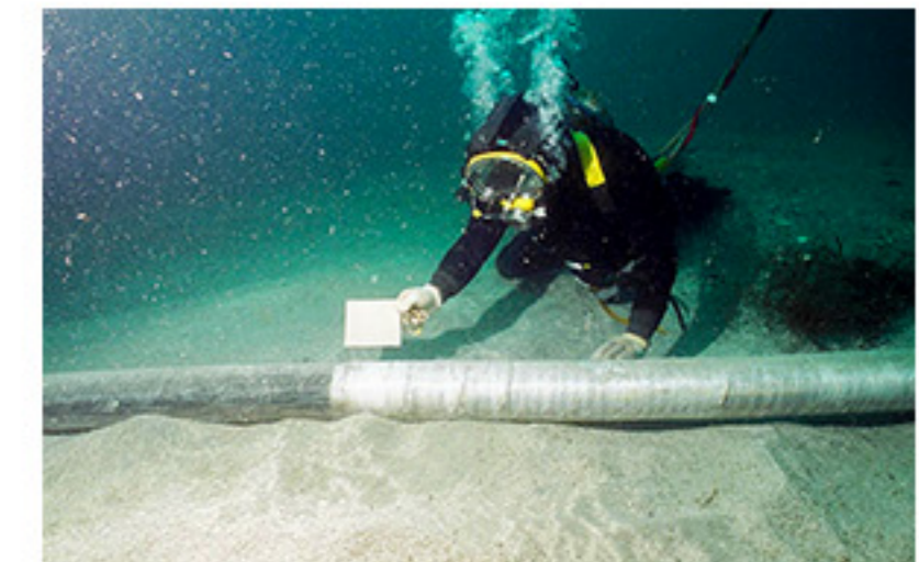
海底ケーブル布設状況 Subsea cable laying
