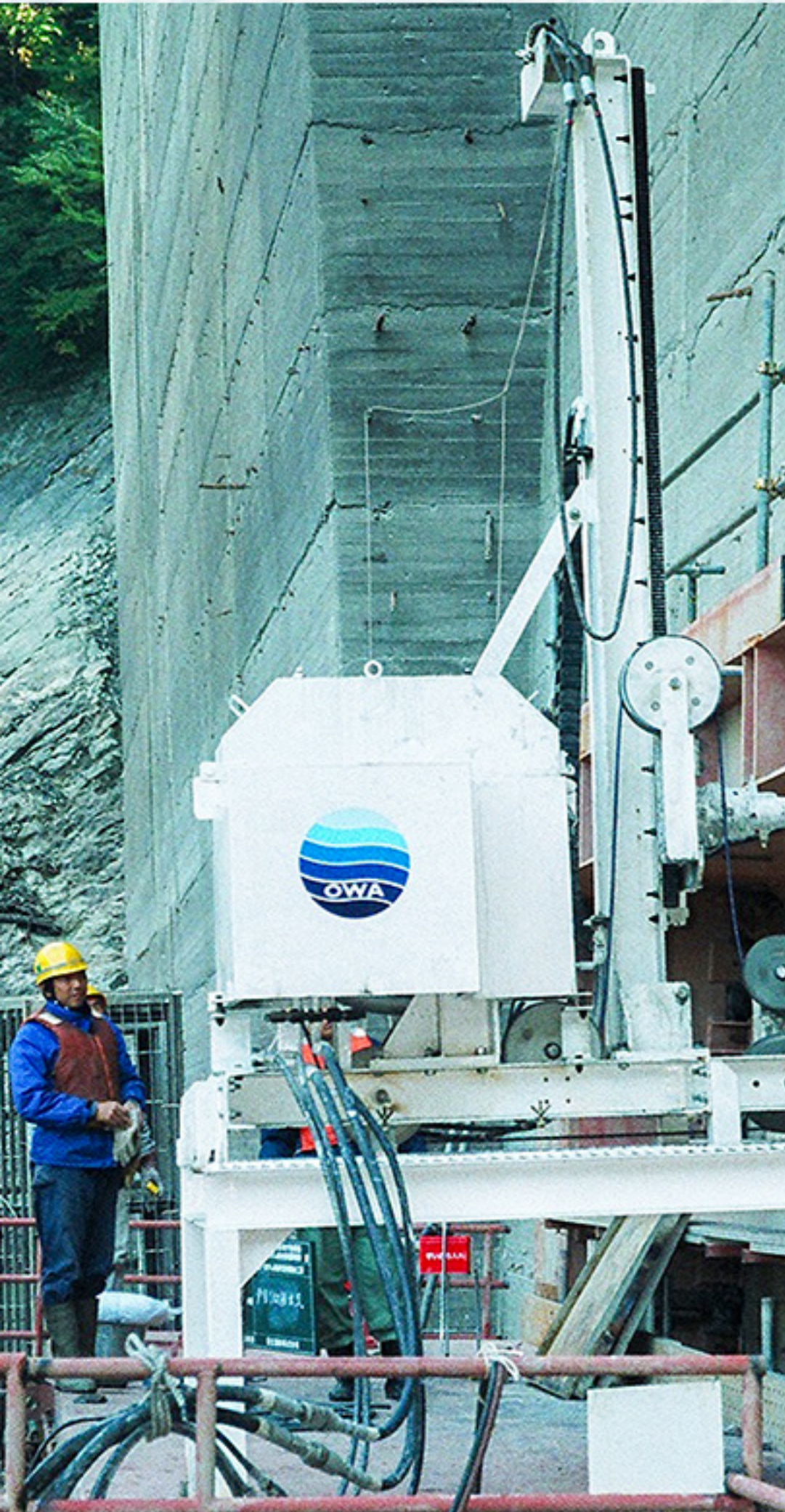
水中ワイヤーソーシステム Underwater wire-sawing system
