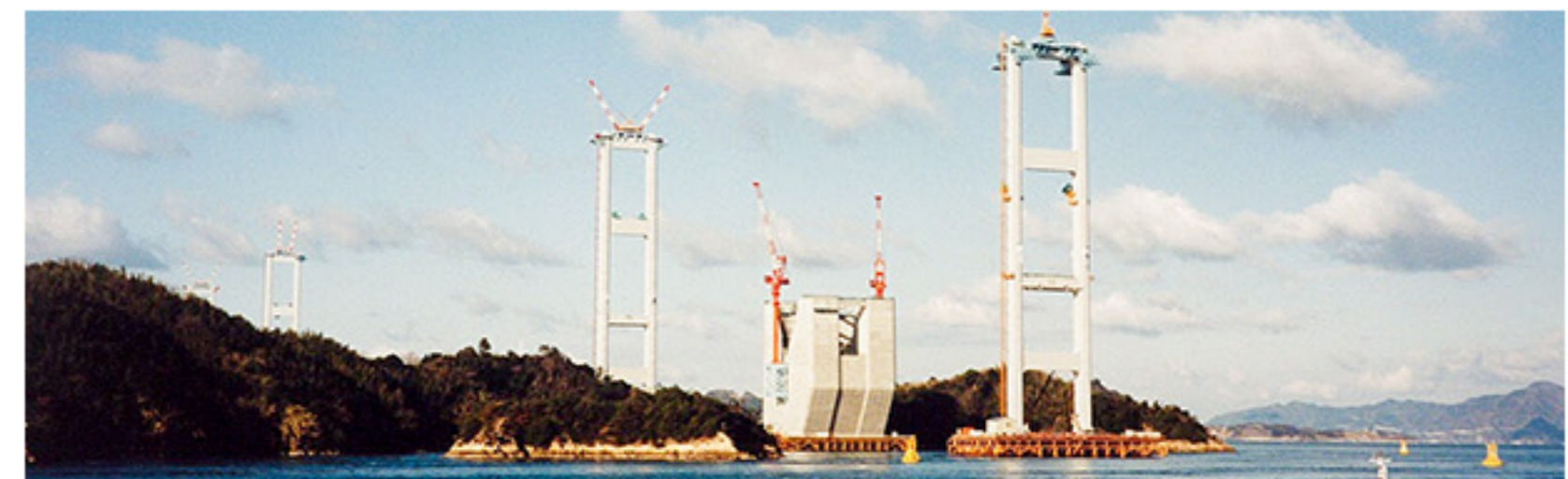
架橋プロジェクト Bridge construction projects
