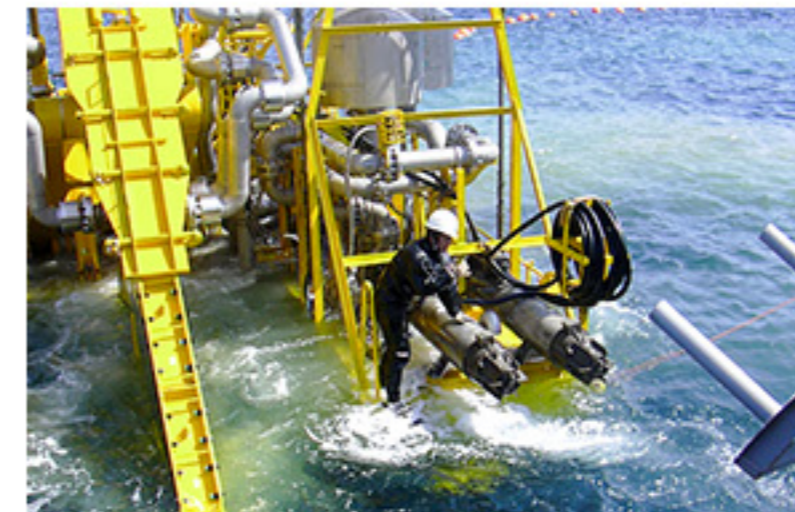
ケーブル埋設機回収作業 Recovery of cable trenching unit
