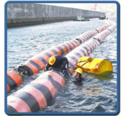
フローティングホース (サブマリンホースとタンカーの間)
