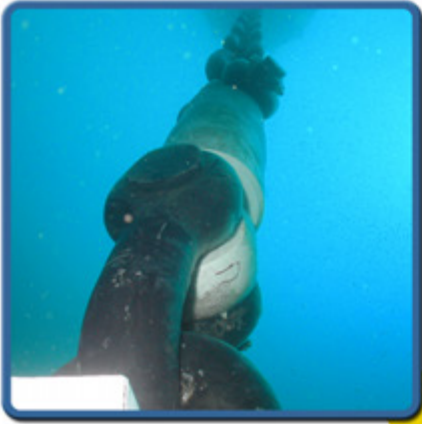
アンカーレグチェーン(フルイドスイベルとSBMをつなぐチェーン)の設置
