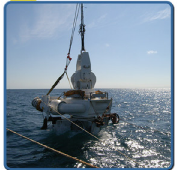
フルイドスイベル(一点係留ブイの土台)を 海底におろす作業
